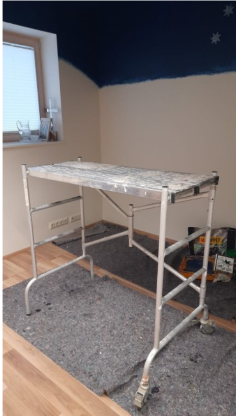
Renovierung des Gemeinderaums
